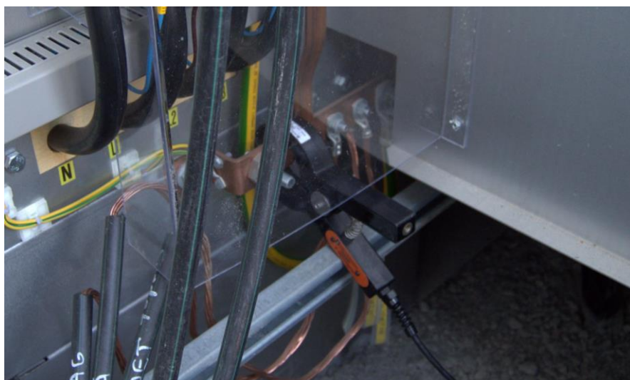
Figur 5. Sändarenhet ansluten på stationsjordningsplint.
