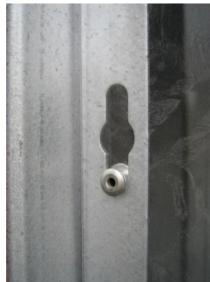
Figur 7. Fästpunkt i nyckelhålsurtag, infallsskydd ZT19/ZF19.
