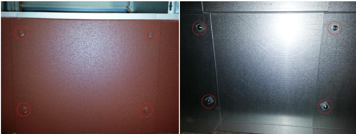
Figur 8. Demontering fundament ZT19/ZF19 (utsida resp. insida).
