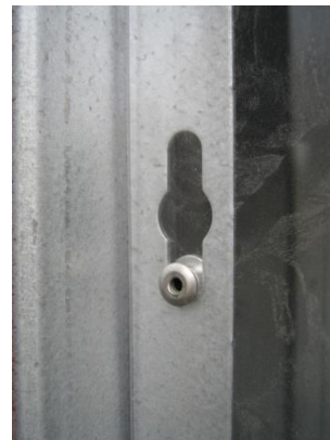
Figur 7. Fästpunkt i nyckelhålsurtag, infallsskydd ZT19/ZF19.
