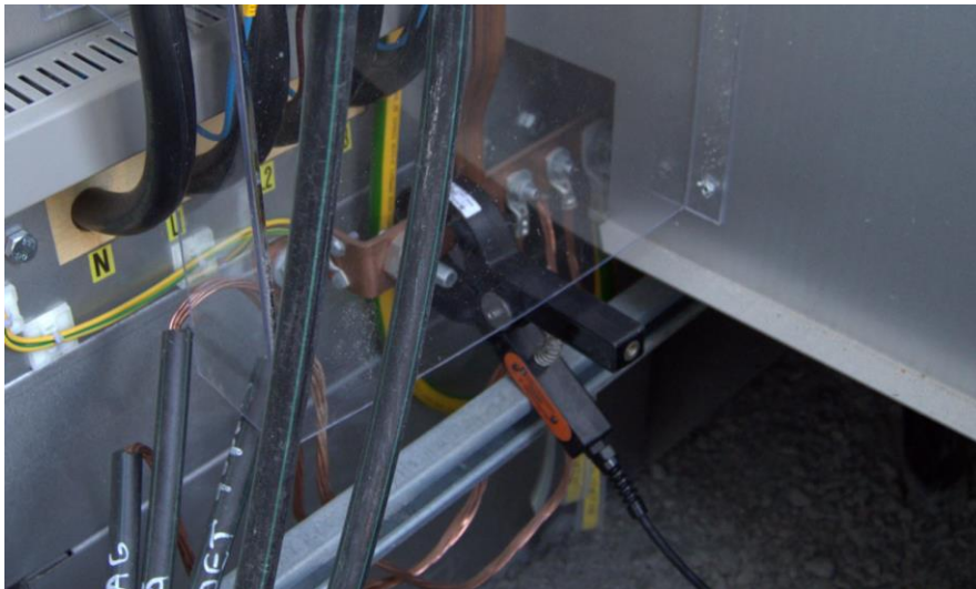
Figur 4. Sändarenhet ansluten på stationsjordningsplint.
